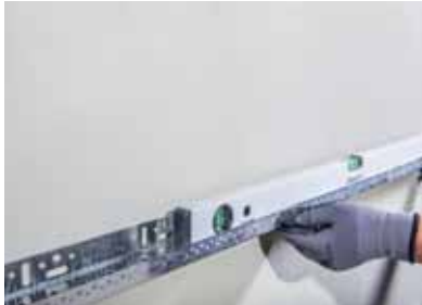
Снимка 1 Празнините, вдлъбнатините и издатините между стената и профила на цокъла на Teknosistem (Socle) цокъл профила се коригират с помощта на дюбели с различна дебелина, а повърхността се измерва с нивелир.
