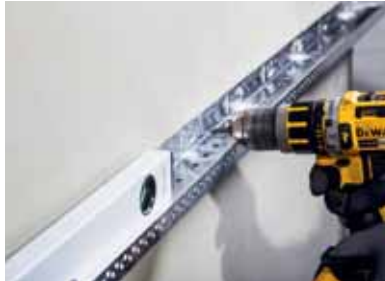
Снимка 2 След процеса на изравняване, Teknosistem цокъл (Socle) профилите се монтират с помощта на стенни свързници.
