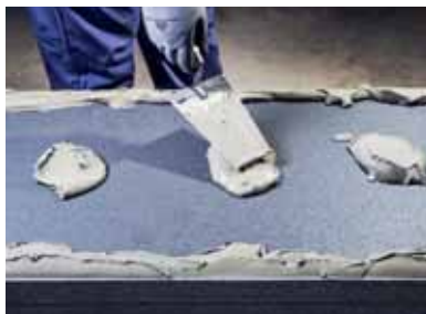
Снимка 2 При наличие на разлики в нивата или неравности на повърхността, адхезивната мазилка се нанася на ленти по всички ръбове на задната част и на точки в средните части на топлоизолационната плоча с мистрия по метода на полагане на ленти и точки.
