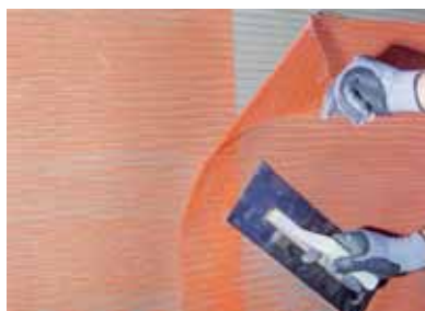
Снимка 2 Мрежата от стъквени влакна трябва да се нанесе върху първия слой на повърхностната мазилка, когато е още влажна, като се притиска с много дълго и широко разтягане, без прегъване и поставяне на еднакво разстояние от изолационната плоча по цялата повърхност за 10 см.
