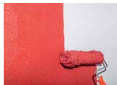
Снимка 3 Накрая се поставя облицовка и се боядисват външните стени.
