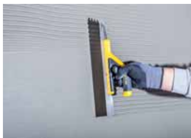
Снимка 1 Залепване на топлоизолационните панели Teknosistem, поставяне на стенните връзки, нанасяне на два слоя повърхностна мазилка. Готовата гипсова шпакловка Teknosistem се нанася върху суха, хомогенна повърхност със стоманена мистрия.
