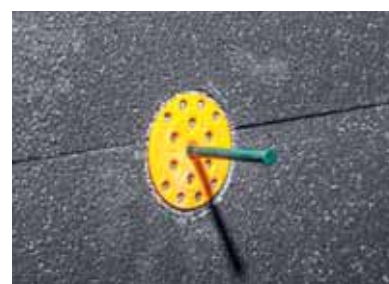
Снимка 3 Стенният плъгин се поставя в отвора и дюбелите се забиват напълно.
