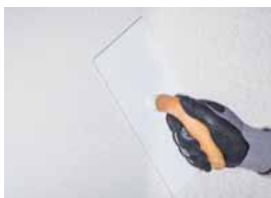
Снимка 2 Нанася се с пластмасова мистрия върху повърхността за образуване на текстура преди изсъхване.
