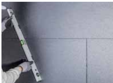
Снимка 2 Нивото на плочите трябва да се провери с нивелир.
