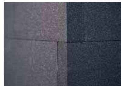
Снимка 3 Топлоизолационните плочи се поставят без празнини и в зигзагообразен стил, започвайки от долната част на стената и вървейки нагоре. Плочите трябва да бъдат положени на зиг-заг в ъглите.
