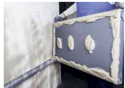
Снимка 3 При полагане на адхезивната мазилка върху гърба на изолационната плоча трябва да се внимава да не се разлее по краищата.
