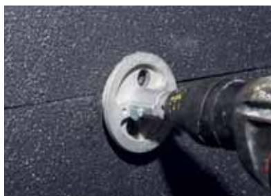
Снимка 1 Необходимо е да се направи вдълбнатина с инструменти, за да се постави напълно главата на стенния плъгин и да се предотврати удебеляване.
