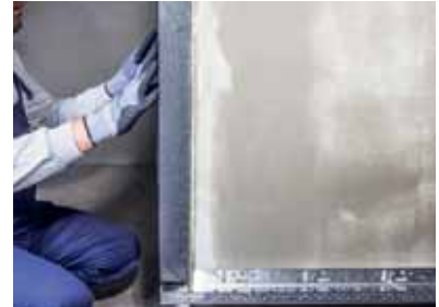
Снимка 3 Размерите на цокълните профили, които трябва да се монтират с разстояние 2-3 mm между тях, се избират в зависимост от дебелината на топлоизолационната плоча, която ще бъде поставена.
