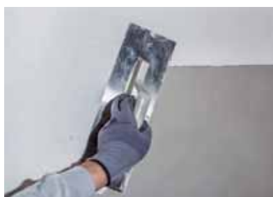
Снимка 1 Teknosistem минерална декоративна мазилка с текстура се нанася върху повърхността с мистрия.
