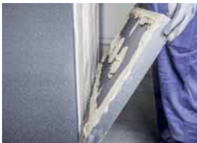
Снимка 1 Топлоизолационната плоча с нанесена отзад адхезивна мазилка трябва да се постави върху цокълния профил без никакви празнини.
